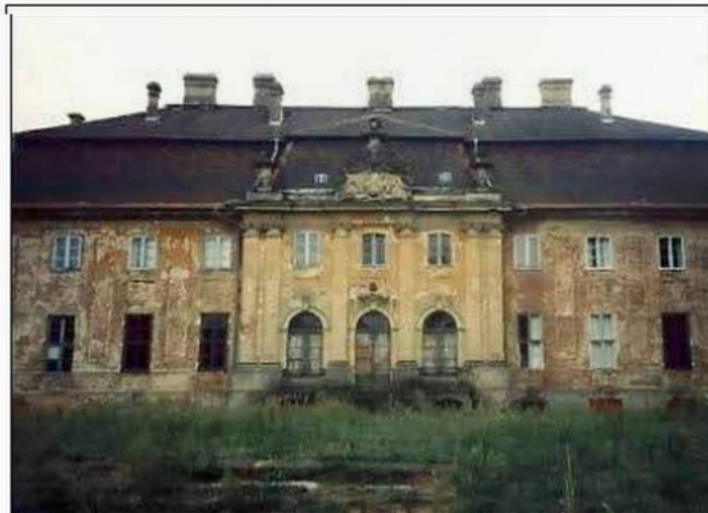
Das Barock-Schloss Meseberg vor der Sanierung.
