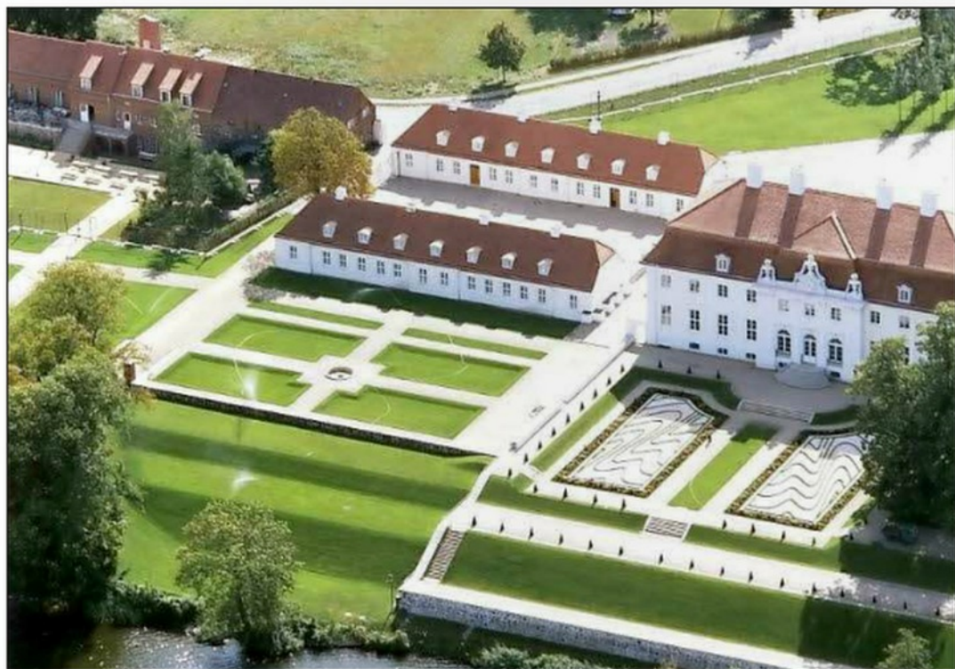
Das neue Gästehaus der Bundesregierung mit Hotel und Gasthof – ein Kleinod, nördlich von Berlin.
